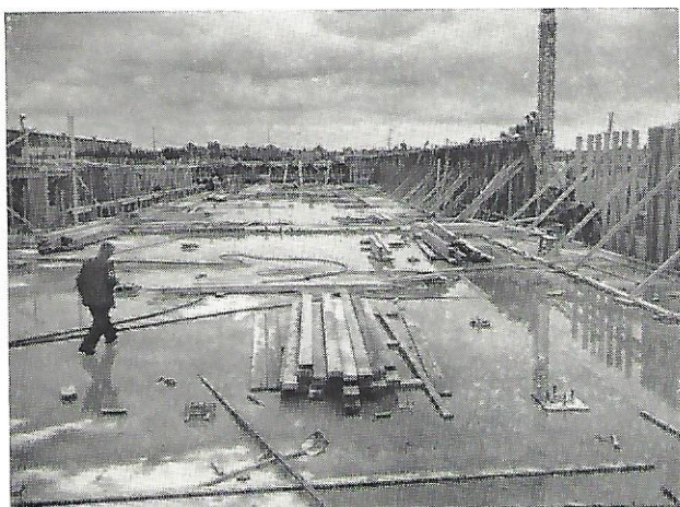
De „Zeegangs-tank” in aanbouw.
